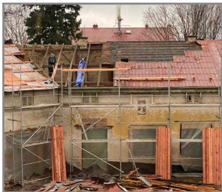
Opravě krovů předcházelo rozkrytí původní střechy
