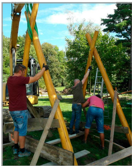
Stavba lanovky se neobešla bez chlapské práce a patřičné techniky
