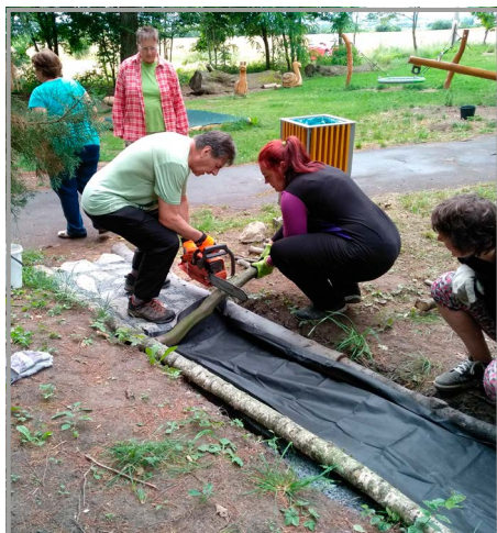
Členové spolku při výstavbě chodníku
