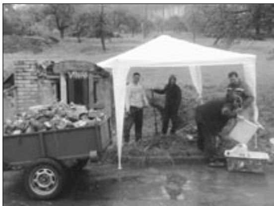
Hasiči na jedné z brigád při opravě průčelí zámeckého vodovodu
