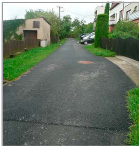
Opravená místní komunikace v části na Letnou
