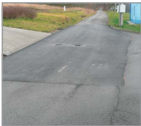
Opravená část místní komunikace u rybníka
