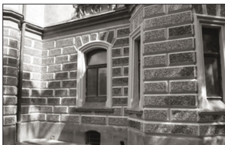
Nově restaurované bosáže na jižní části zámecké budovy.
