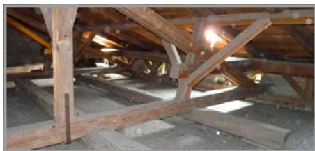
Vazba zámecké střechy je skutečným mistrovským dílem starých tesařů
