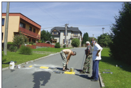
Montáž retardéru na „Betonce“.
