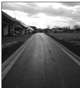
Nově dokončená komunikace v ulici „U Mlýna.“
