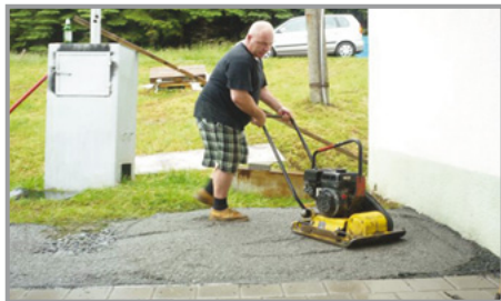
Pokládka nové dlažby u myslivecké chaty.
