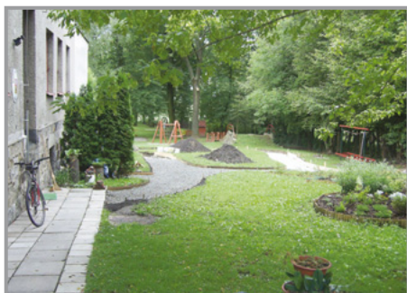
Výstavba nové koloběžkové dráhy.
