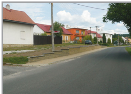
Nově vystavěná část opěrné zídky.
