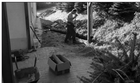
Brigáda na odkanalizování dešťové vody.
