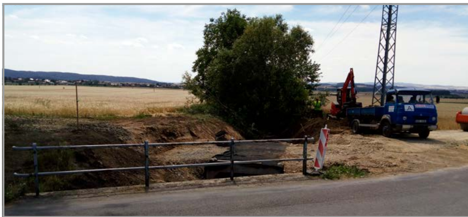
Stavebně nejobtížnější částí cyklostezky je můstek přes Přílepský potok
