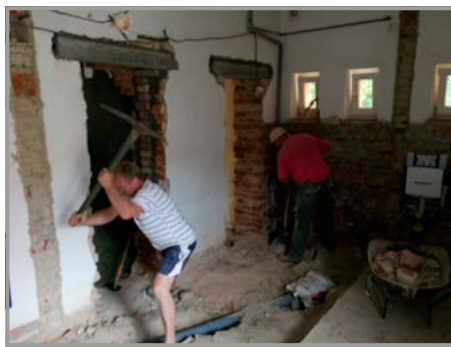
Zbudování nového hygienického zázemí předchází rozsáhlé bourací práce
