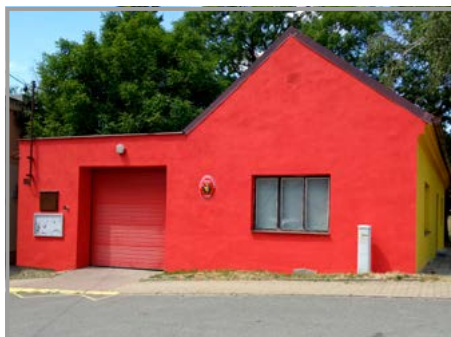
Průčelí zbrojnice SDH Přílepy s novou fasádou
