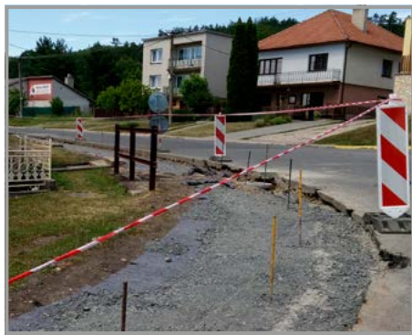
Příprava podloží chodníku
